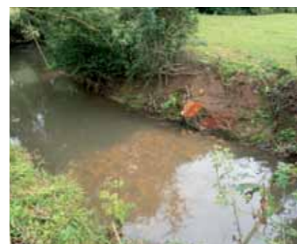
Réalisation d'un seuil de fond.
