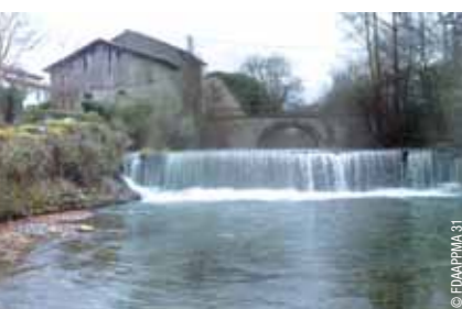
Seuil du pont de la route d'Izaut sur le Ger.
