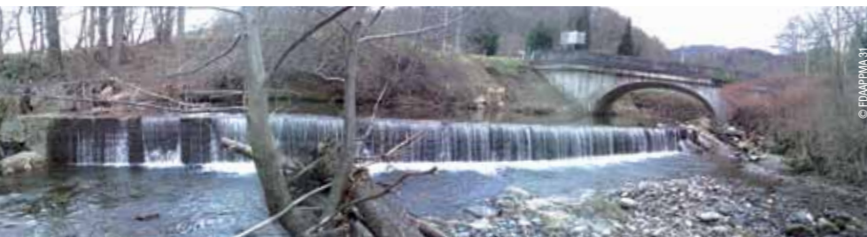
Seuil du pont de Giret sur le Ger.
