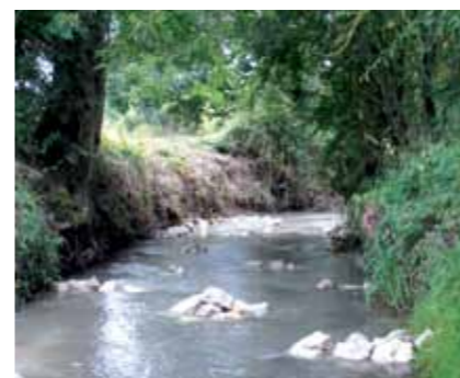
Diversification des écoulements par pose de blocs.
